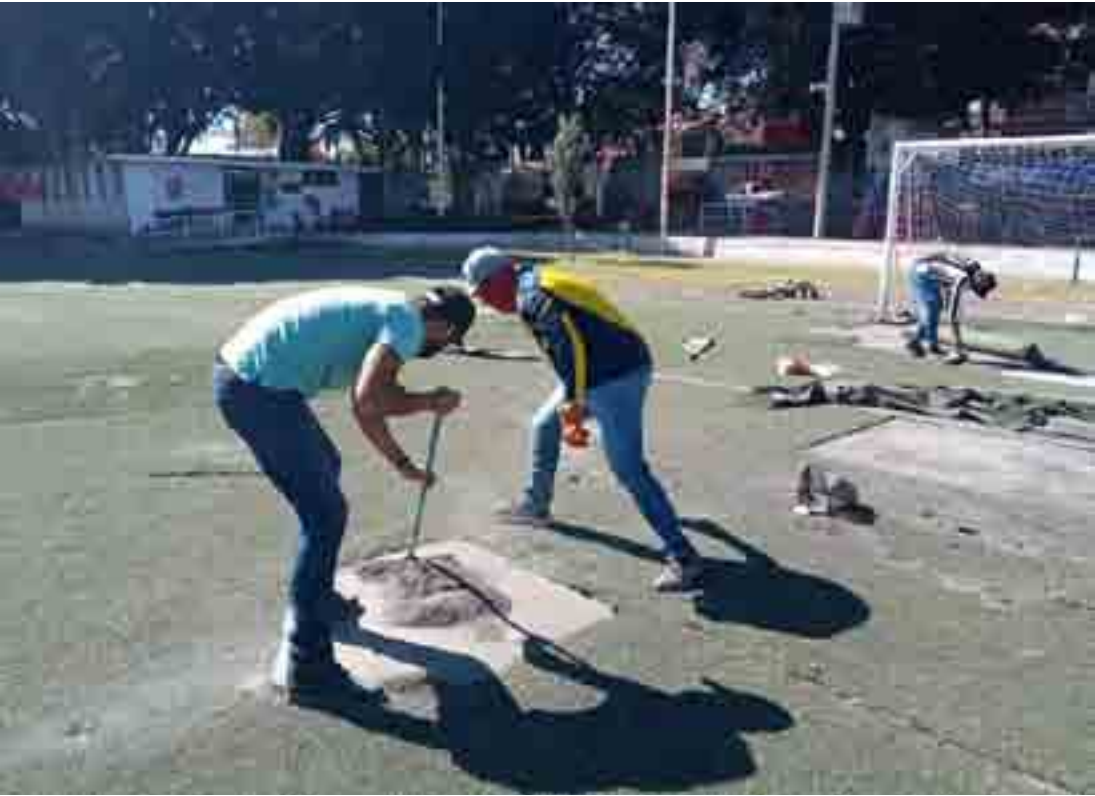
Otra gráfica del trabajo para rehabilitar el césped de la cancha de futbol de la Unidad Deportiva “Morelos”
