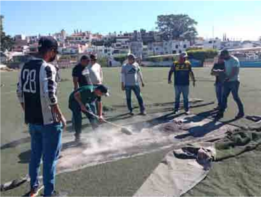
Personal del IMCUFIDE reparando la cancha de césped sintético
