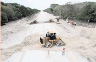
En el Tramo 5
