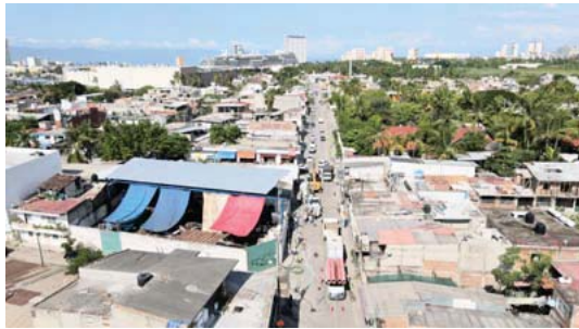
Obra para evitar riesgos sanitarios
