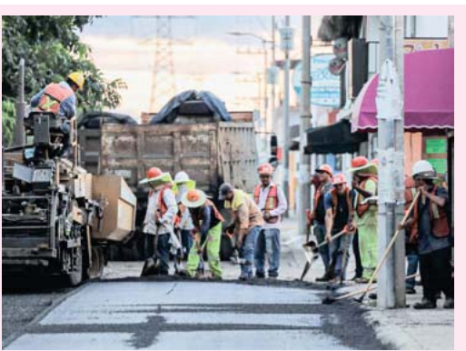
Arrancaron los trabajos de pavimentación en Valle Dorado
