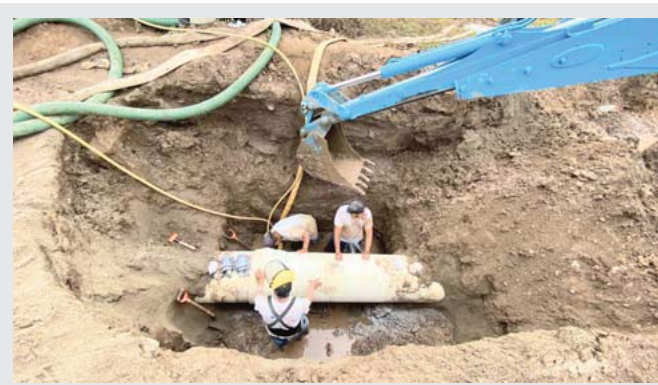
En materia de agua y drenaje
