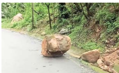
Deslaves, derrumbes, árboles y ramas caídos sobre la cinta asfáltica
