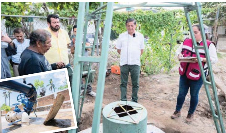
Concluyen obras del Pozo 26 "A"
