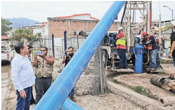
Supervisa alcalde perforación del Pozo 26 "A"
