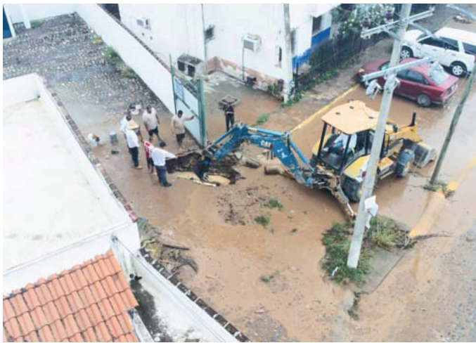
Prioritario para el organismo avanzar en las tareas de reparación de tubería por fugas
