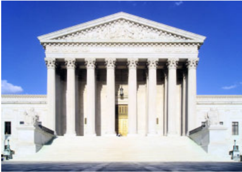
Compensarán los daños
