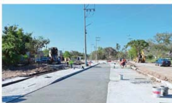
PAVIMENTACIÓN EN CONCRETO HIDRÁULICO AVENIDA FEDERACIÓN -COLONIA CAMPESTRE LAS CAÑADAS-
