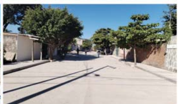
PAVIMENTACIÓN EN CONCRETO HIDRÁULICO CALLE 10 DE MAYO -COLONIA EL MANGAL-
