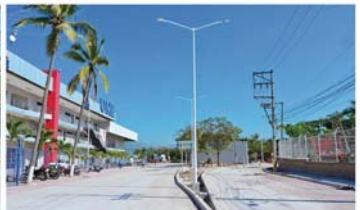
PAVIMENTACIÓN EN CONCRETO HIDRÁULICO CALLE FRANCISCO MURGUIA -DELEGACIÓN LAS JUNTAS-
