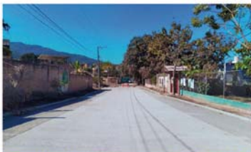
PAVIMENTACIÓN EN CONCRETO HIDRÁULICO CALLE SANTA MARÍA -COLONIA LA MODERNA-
