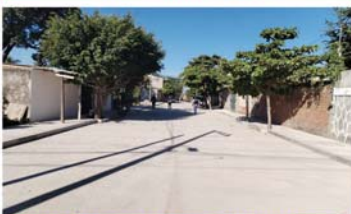
PAVIMENTACIÓN EN CONCRETO HIDRÁULICO CALLE 10 DE MAYO -COLONIA EL MANGAL-
