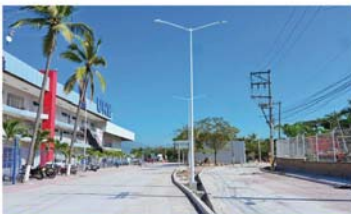
PAVIMENTACIÓN EN CONCRETO HIDRÁULICO CALLE FRANCISCO MURGUÍA -DELEGACIÓN LAS JUNTAS-
