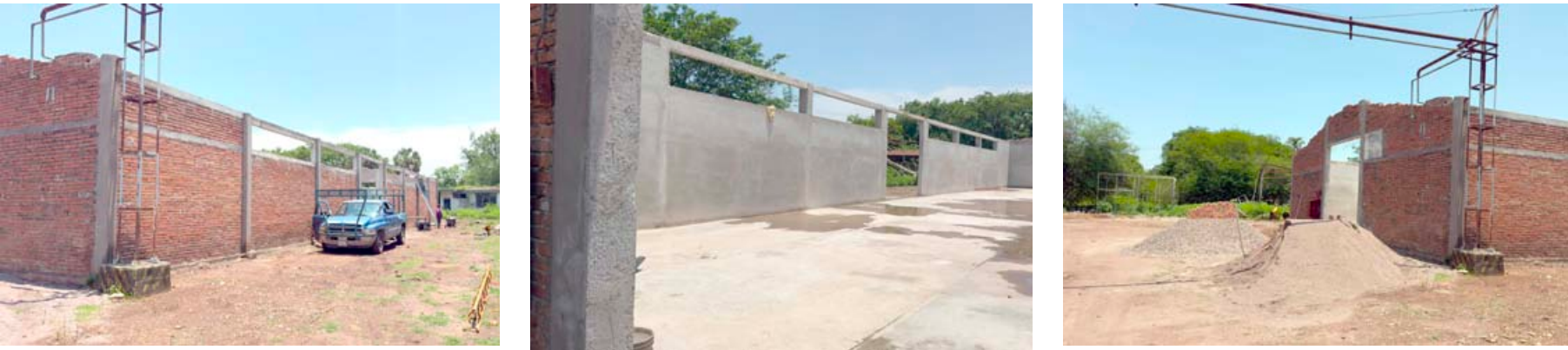
REHABILITAN BODEGA DE GRANOS
