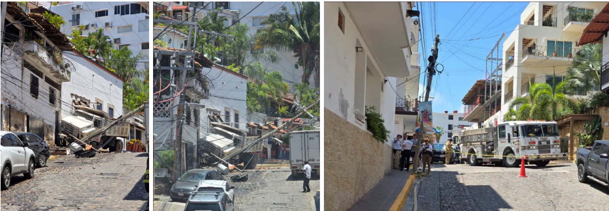
Góndola derriba poste de CFE
